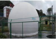
沼气收集装置 Biogas collector
